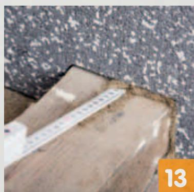
Prije armiranja treba kudjeljom začepiti pukotinu između izolacijske ploče i drvene grede. U tu svrhu se ručno razdvije vlakna izolacijskih traka IDS Hanf-Filz Dämmstreifen i vunu treba ugurati u pukotinu npr. pomoću sklopivog metra
